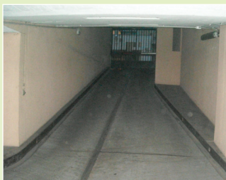
Foto 3 - Rampa accesso ai garage sotterranei
