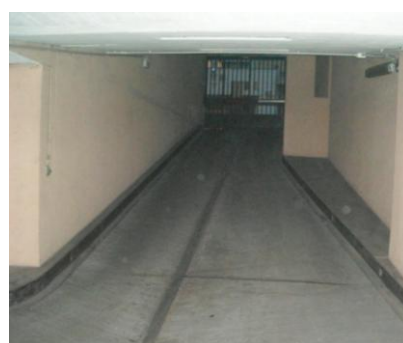
Foto 3: Rampa accesso ai garage sotterranei
