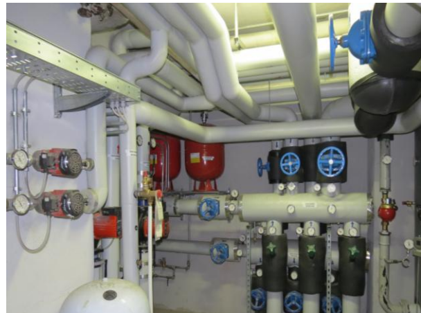
Foto 2: Coibentazione Sala Tecnica
